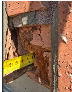
Sondage sur brique cassé sur site
